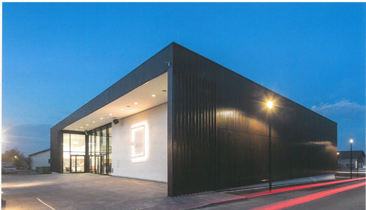
Das Veranstaltungszentrum 4Kanter präsentiert sich mit einer Lärchenfassade in VEH AB-Qualität. Beschichtet wurde das Holz mit dem Adler Lignovit-Farbtönen „Darth Vader“.
